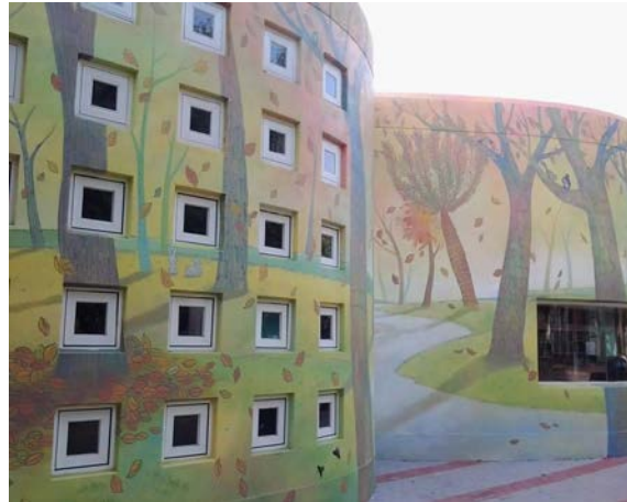
圖 10：社區閱讀中心東側外牆
